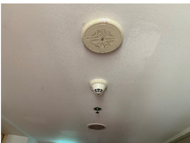
smoke detector และ sprinkle fire
